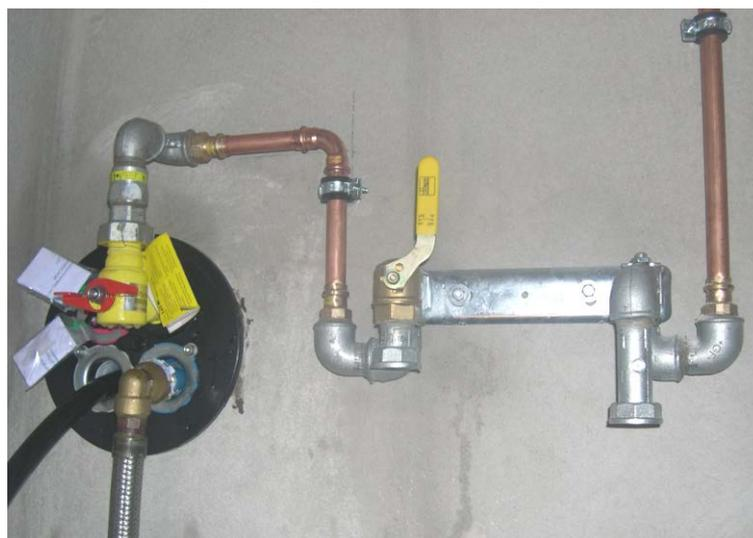
Abbildung 7.2: Gaszähler-Anschlussplatte bei Kunststoffleitungen in der Gas-Hausinstallation
