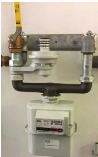
Abbildung 8.1: Einrohr-Gaszähler mit Passstück an einer Zweirohr-Gaszählerplatte mit Zählerregler
