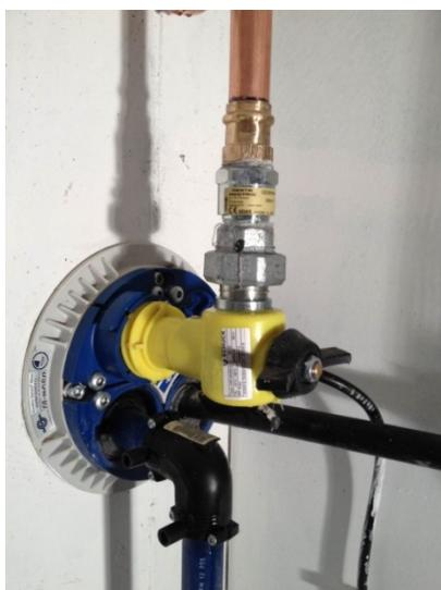
Abbildung 4.3: Beispiel einer Mehrsparten Hauseinführung
