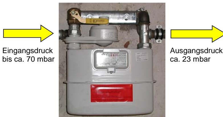
Alternativ kann in Mitteldruck-Gasnetzen ein Hausanlagenregler (unmittelbar nach Eintritt der Gas-Netzanschlussleitung in das Gebäude) Verwendung finden.
