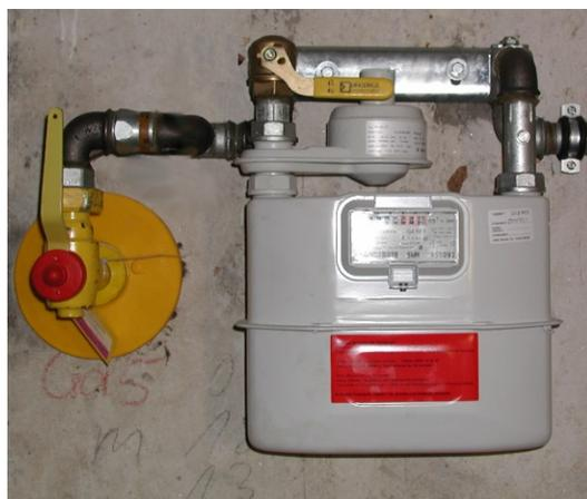
Abbildung 4.5: Einzelspartenanschluss mit Gaszähler und Zählerregler
