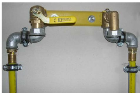
Abbildung 7.3: Gas-Zähleranschlussplatte – Anschluss mit nicht metallenen Leitungen
