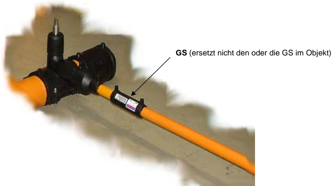
Abbildung 4.1: Verteilungsleitung mit Netzanschlussleitung und Gasströmungswächter (GS).
